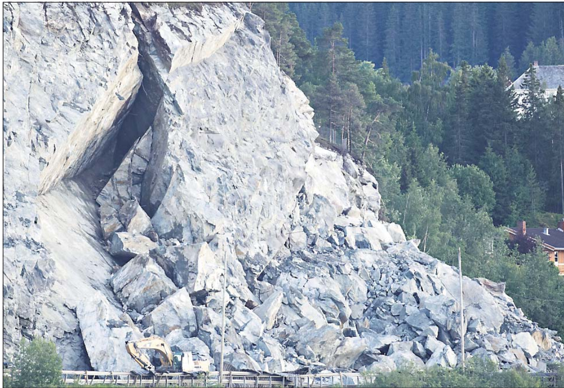
USTABIL: 8.000 kubikkmeter stein raste ut under bygging av ny E6 i Løsberga 30. juni 2008.
